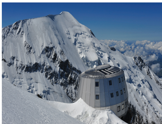
Le Refuge du Goûter, Saint Gervais, France - Architects: Groupe H and Déca-Laage. © Pascal Tournaire
